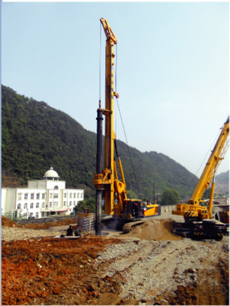
XR280D贵阳施工
