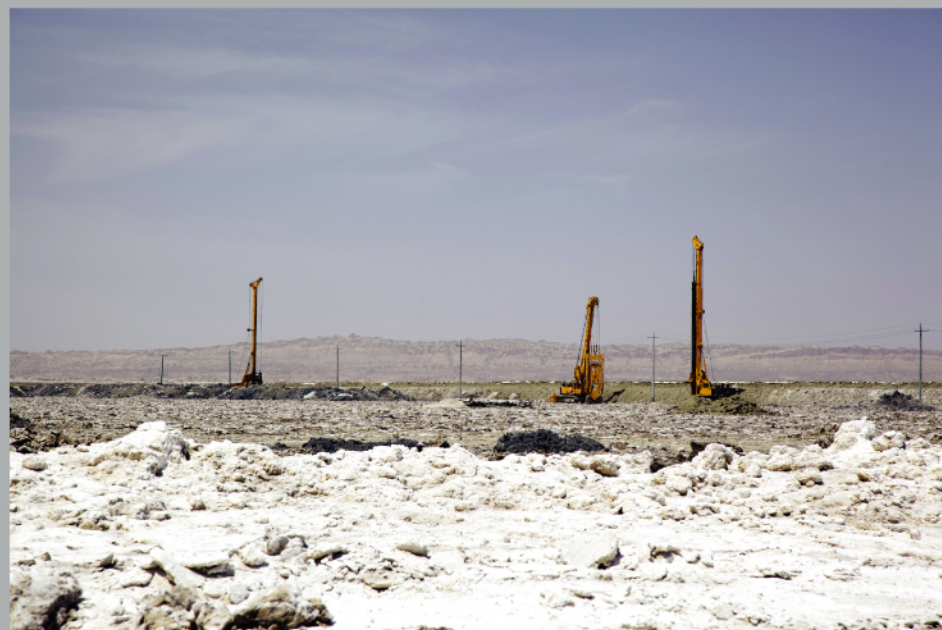
徐工旋挖钻连续墙新疆施工
