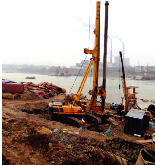
SRS1050重庆施工
