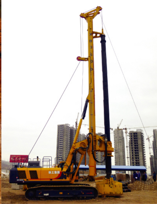
XR360甘肃施工
