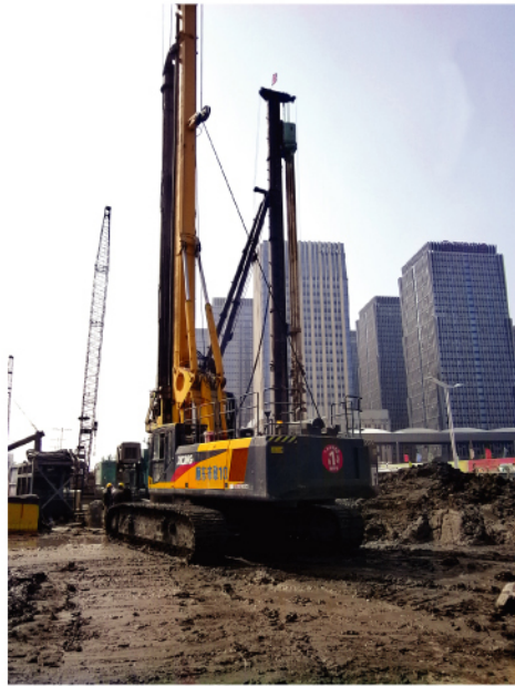
XR280D南京市政施工
