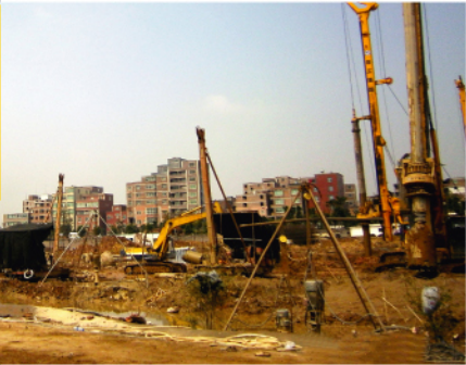
泉州徐工旋挖钻机群施工
