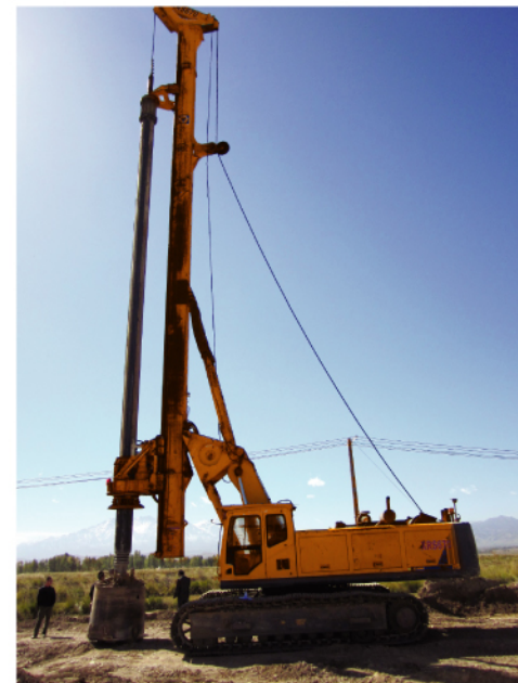
兰新铁路施工
