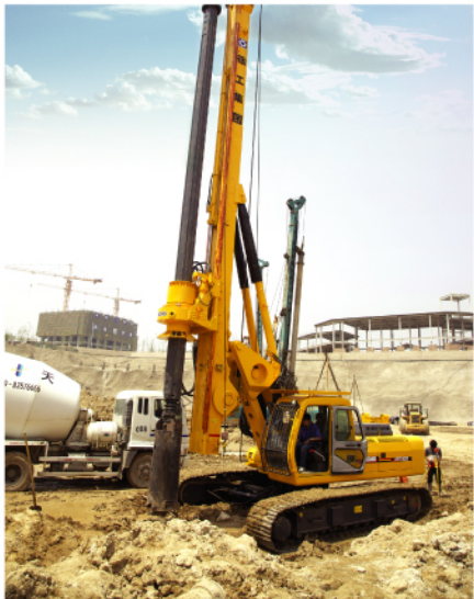
西安浐灞新区施工
