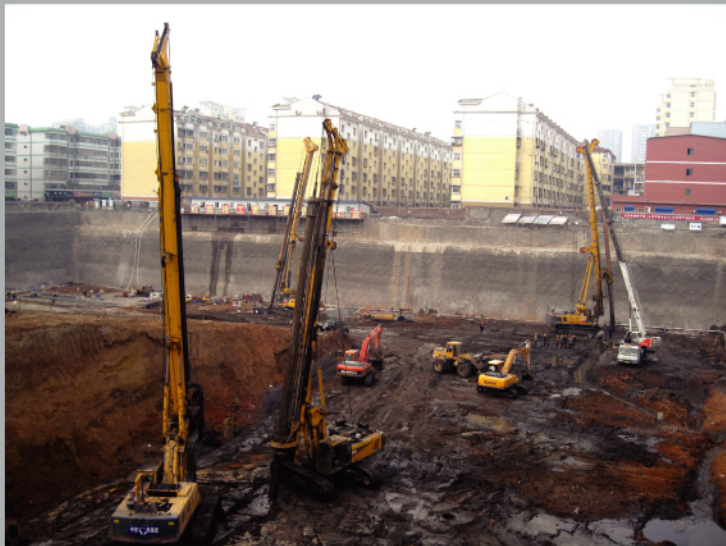
山西徐工旋挖钻机群施工
