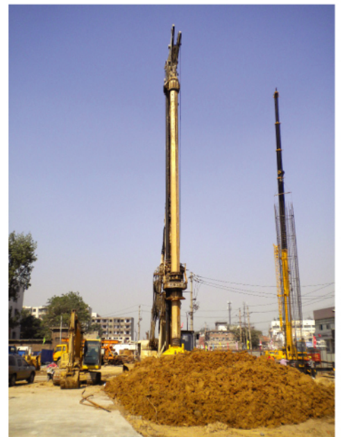
郑州高架桥施工现场
