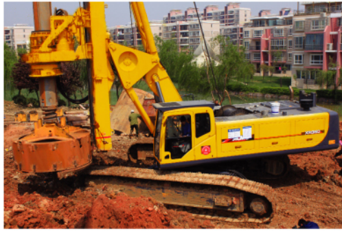
合肥绕城高铁施工
